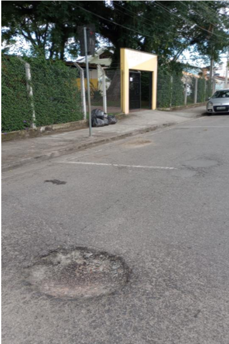
Foto 1: Rua Nenê Namura Abib, Bairro Residencial e Comercial São Paulo.
