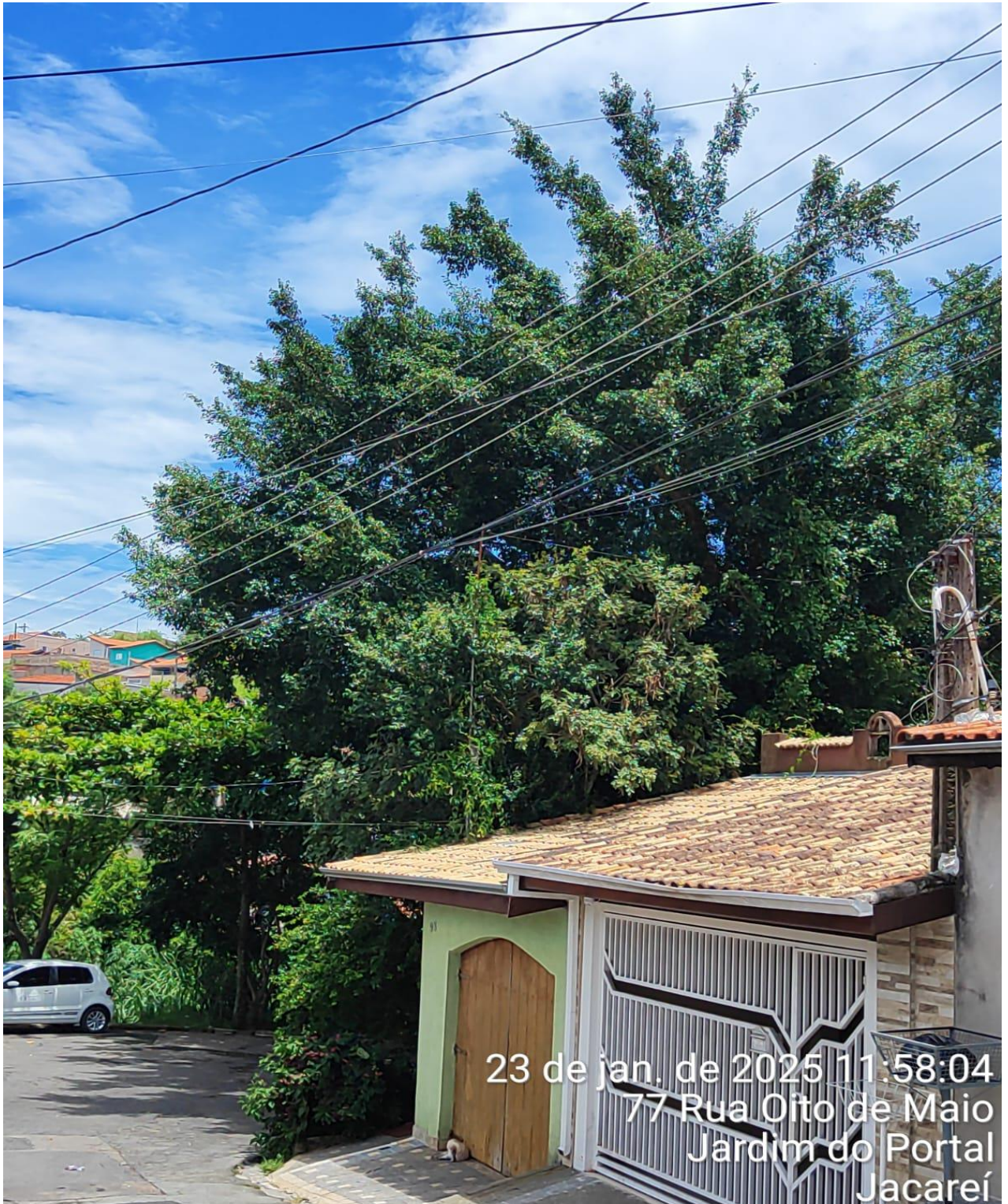
Foto: Árvores com galhos entre a rede elétrica e muito próxima das casas.
