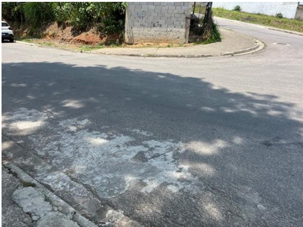
Foto 2 - Esquina na Rua Potiguara com a Rua Xurucu
