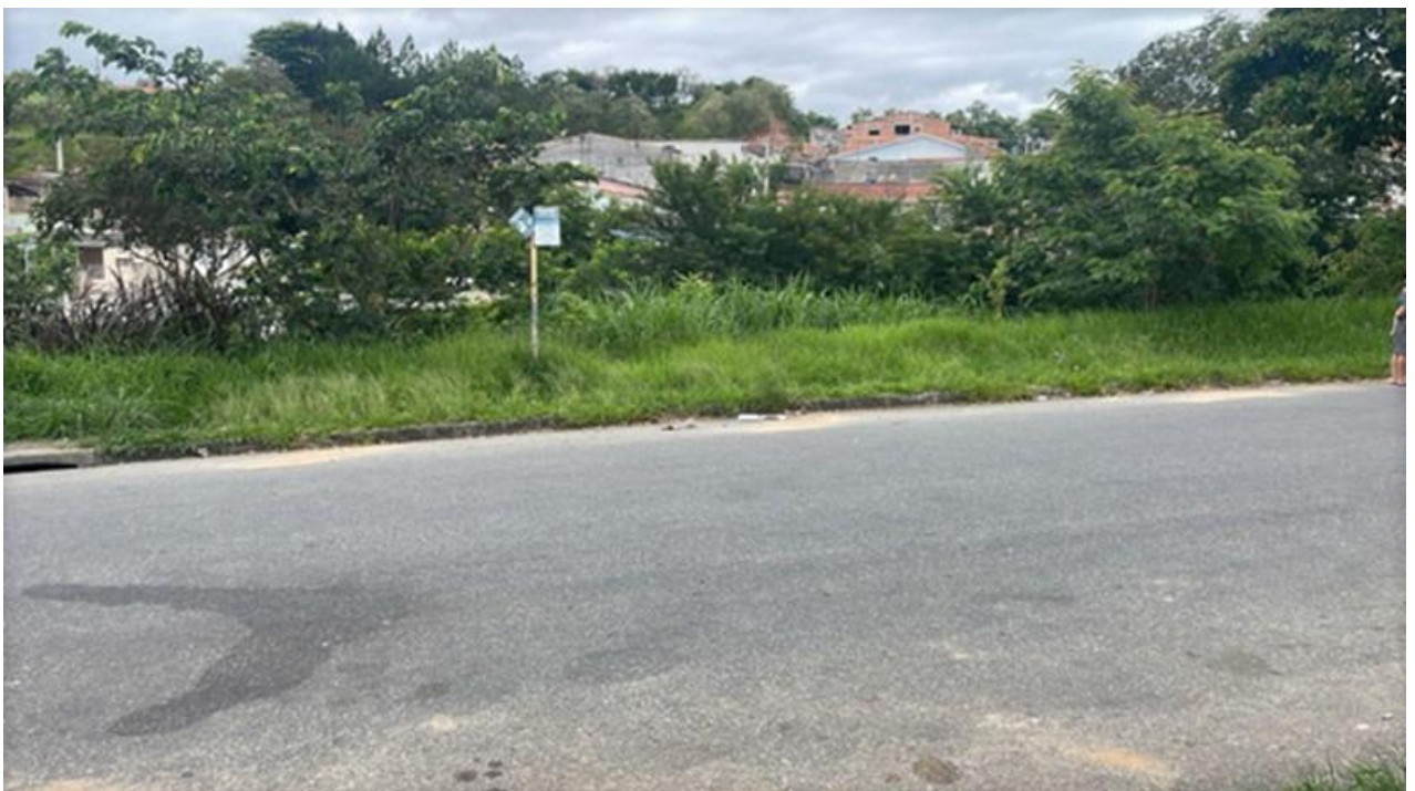
Fotos 1 e 2: Avenida Vereador Joel Alves, próximo ao nº 60, no Parque Imperial
