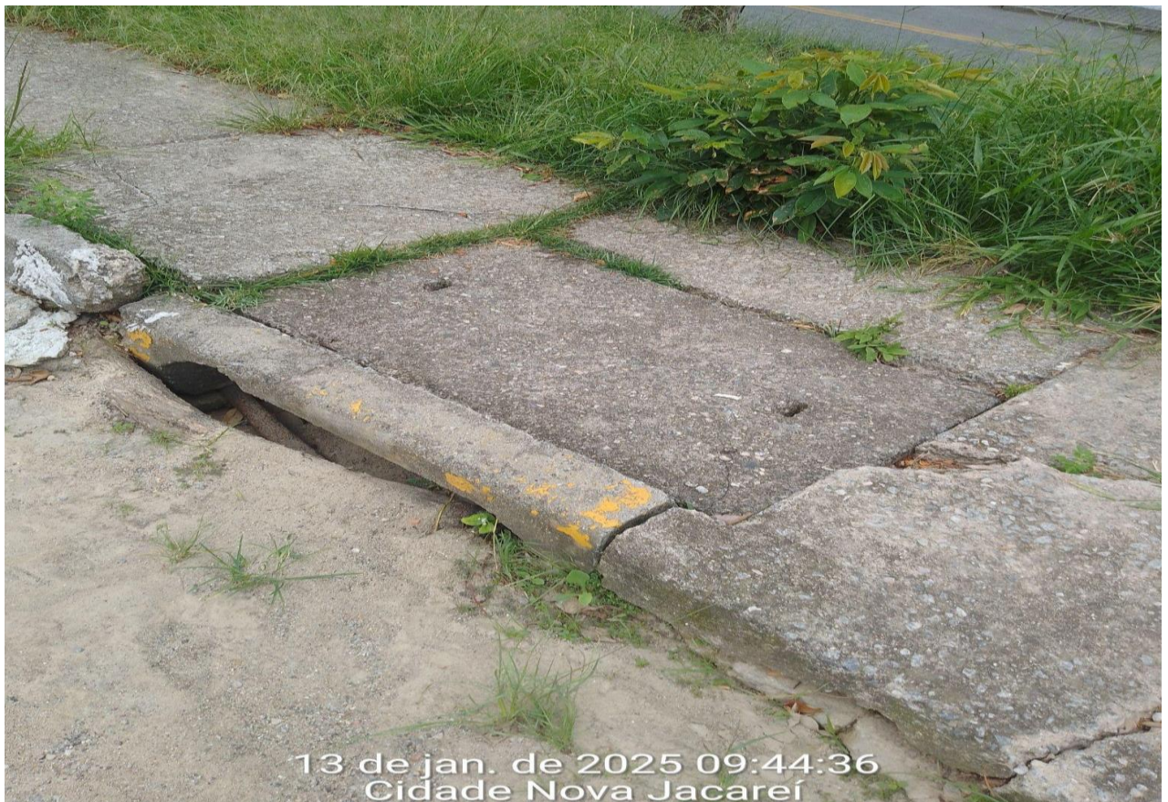
Foto 6: Manutenção da boca de lobo da Rua Gaspar Gomes da Costa, nº 727
