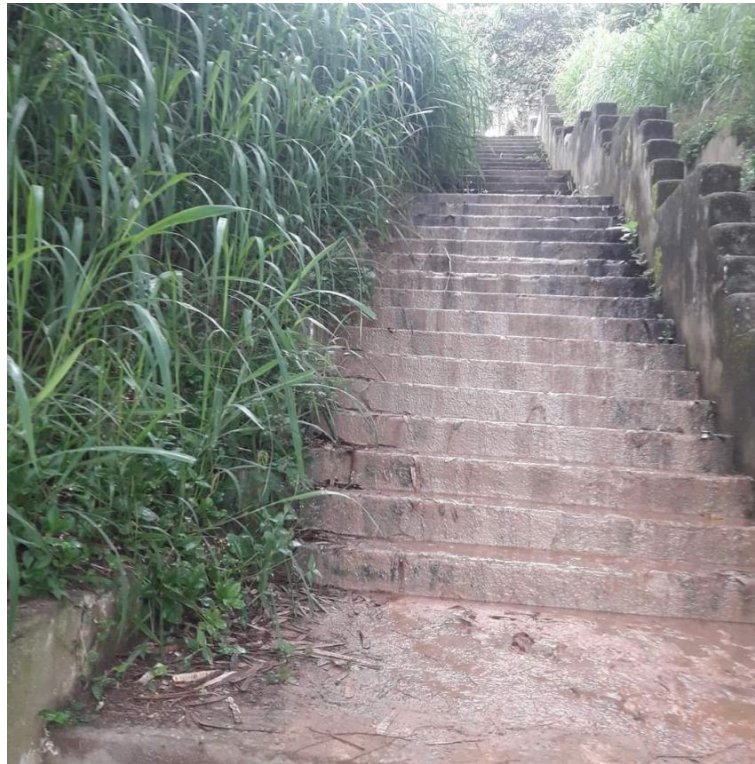
Item 1. Escadão na Rua Gaspar Gomes da Costa, próximo ao nº 293, no Bairro Cidade Nova Jacareí
