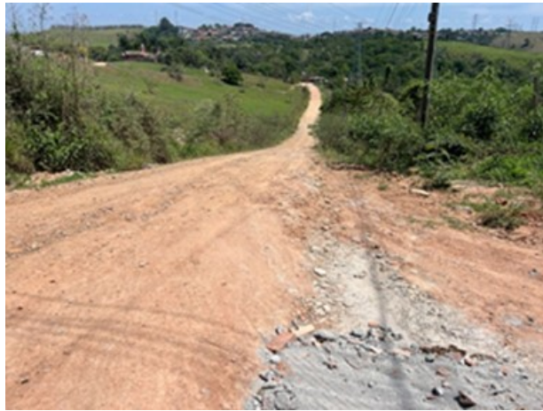
Fotos 1, 2 e 3: Rua Henrique de Araújo, no Jardim Olympia
