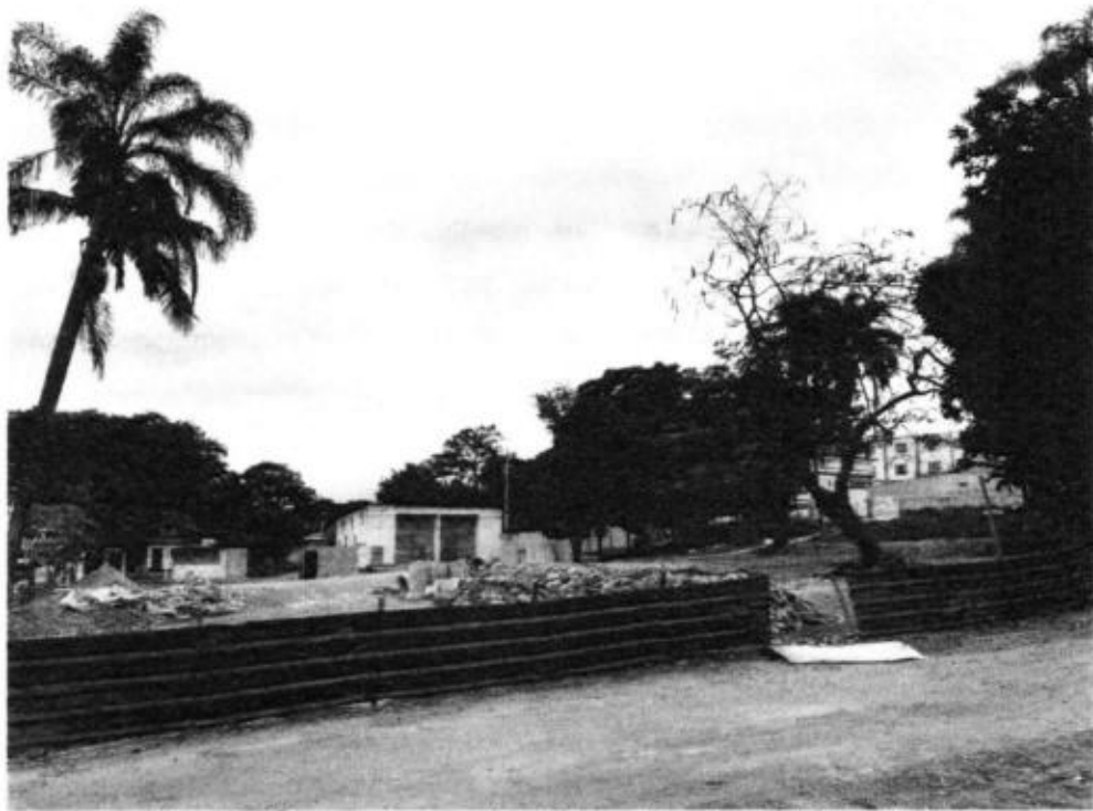
Figura 2 - Área usada para obras de canalização - Matrícula 60.596
