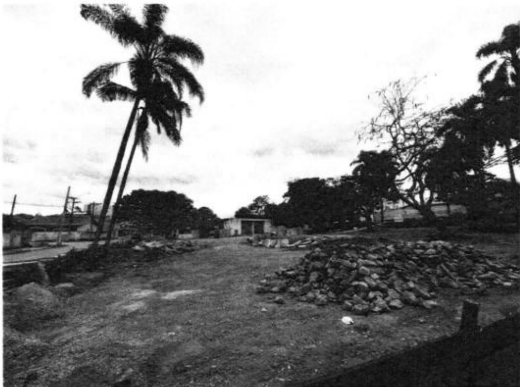
Figura 3 -Entulho das obras de canalização - Matrícula 60.596
