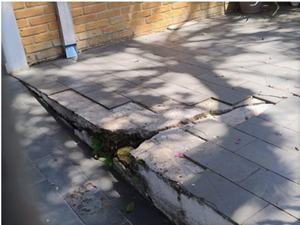
Fotos 4 e 5: Rua São Marcos, nº 461, no Jardim São José
