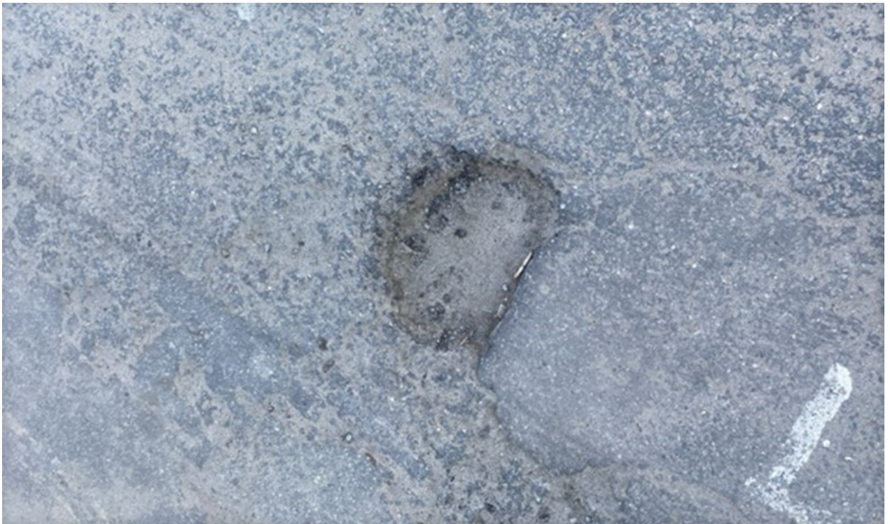
Fotos 1 a 4: Rua Salvador Correa Moreira, no Bairro Cidade Nova Jacareí
