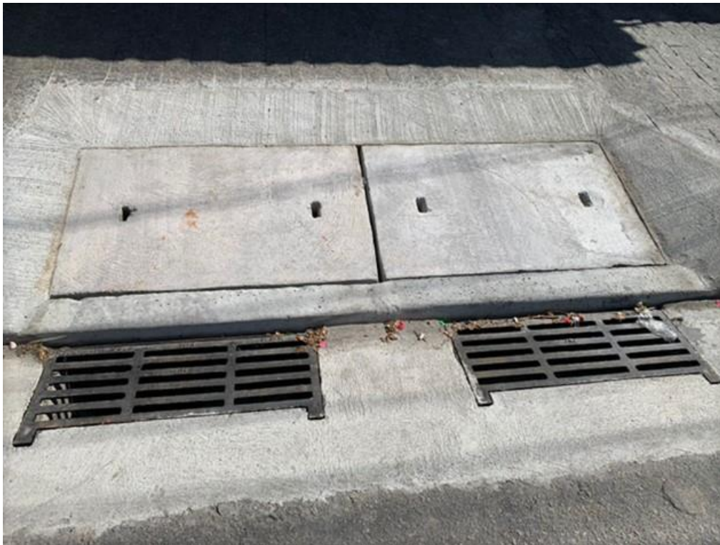
Foto 2: Exemplo de bocas de lobo com grades
